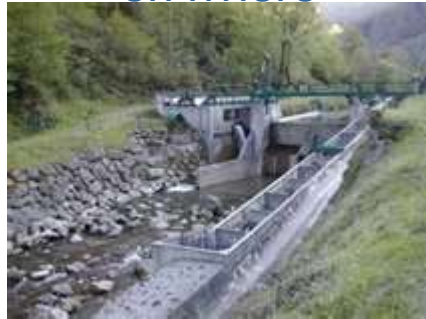
Pompage en rivière
